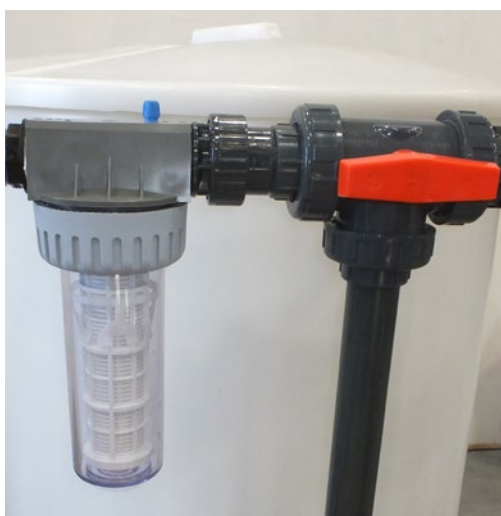
Filtre à usage intensif et soupape à trois voies
